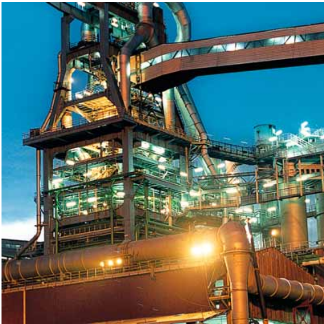
Aplicación industrial: Refinería
